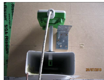
Figure 4: Montaggio anemometro sistema di ventilazione.
