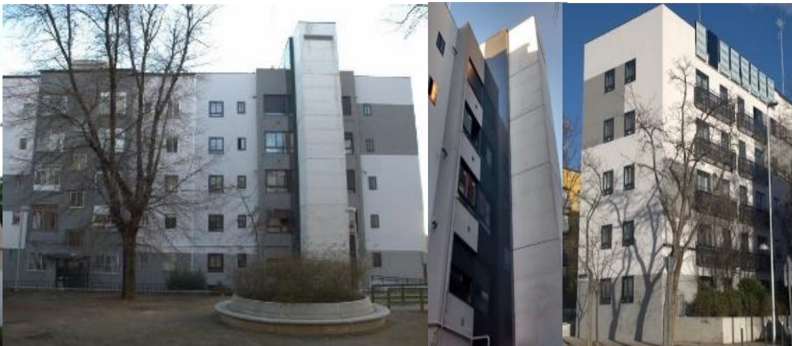
Il condominio dopo il risanamento
